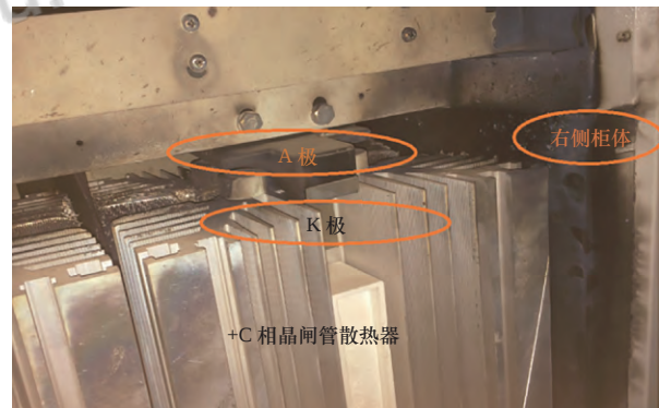
图9 +C 相晶闸管 A/K 短路
