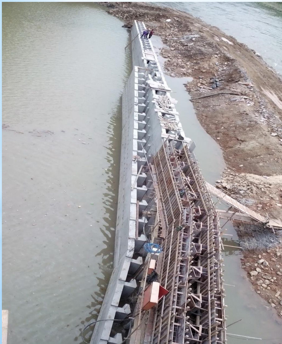
连江龙船厂电站鱼道示范工程
