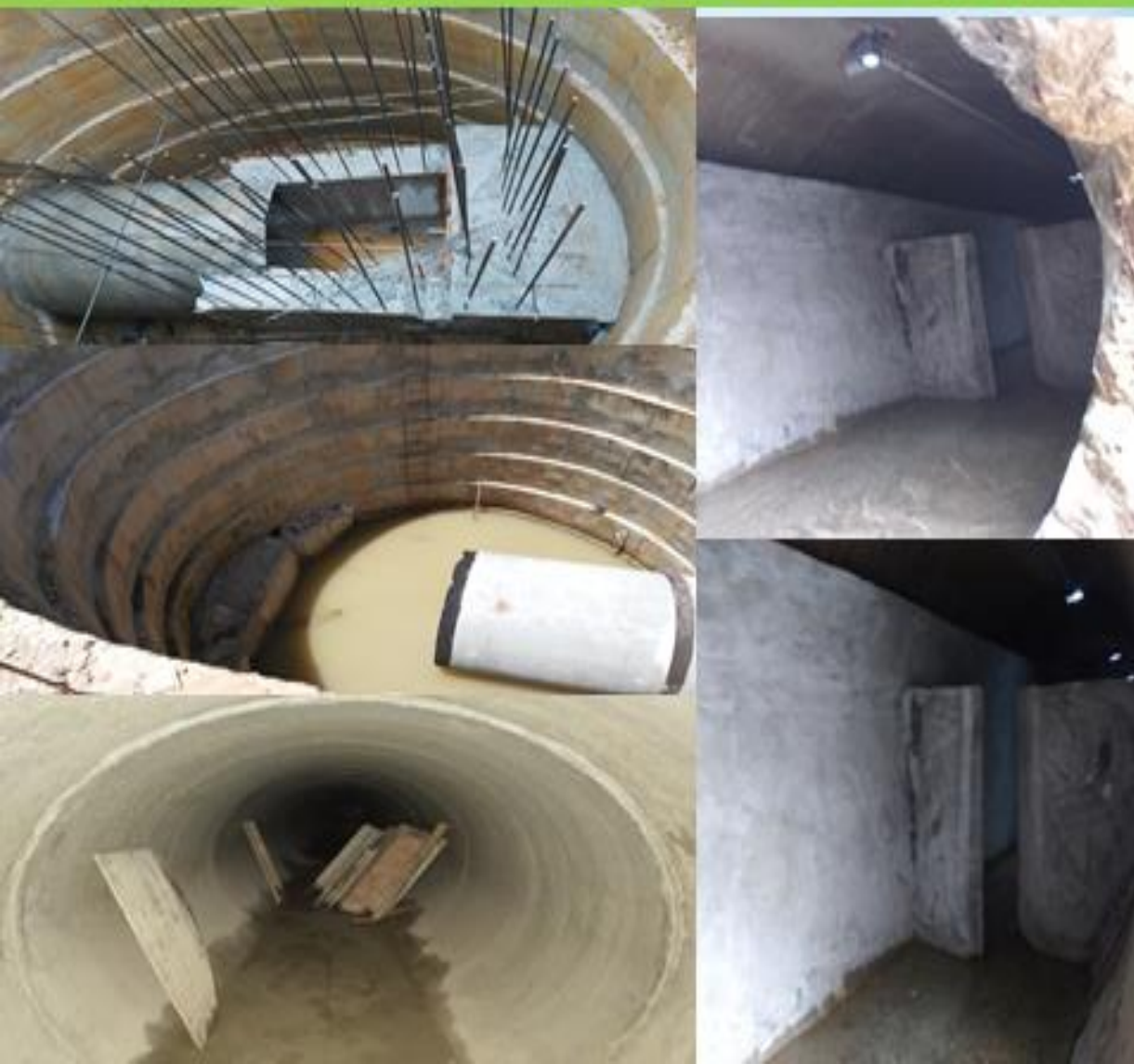
东江柳城电站、蓝口电站涵管工艺鱼道示范工程
