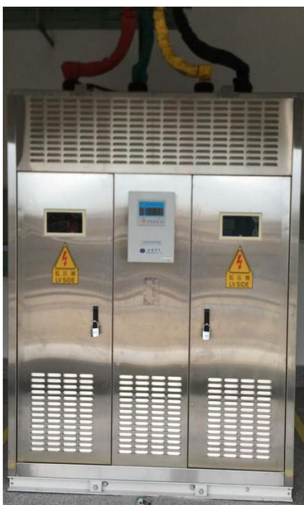
图21 更换后的干式变压器
