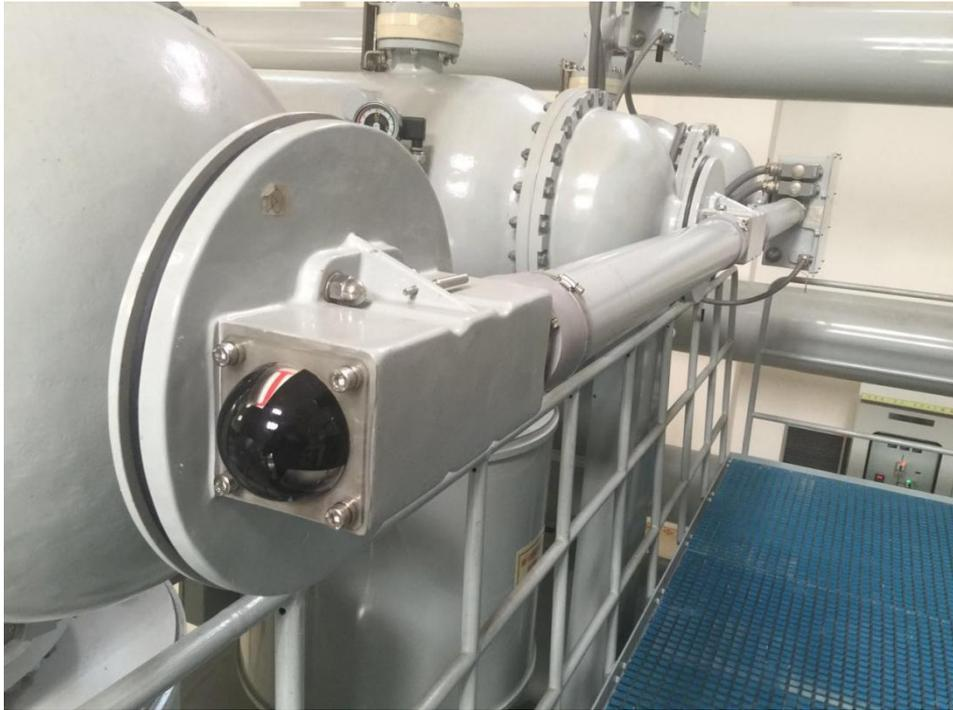
3. 结合设备检修完成某电站 GIS 隔离、接地刀闸分合闸位置指示安装完善。
