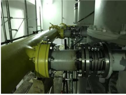
图 2 改装不锈钢波纹伸缩管
