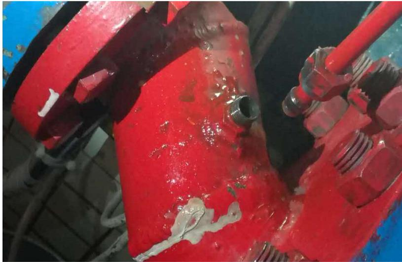
1F 机组停机时，事故配压阀前端至 42DP 的油管拆分后无明显漏油情况
