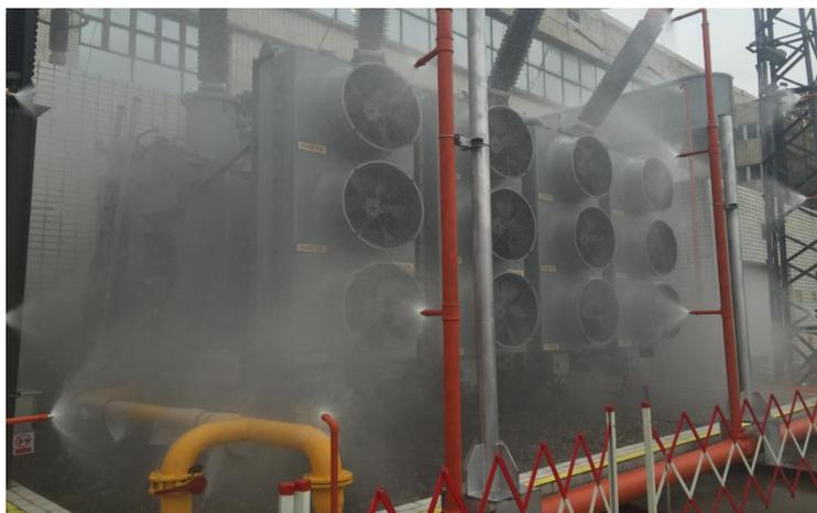
图 17 主变压器消防喷淋系统改造后效果实拍图
