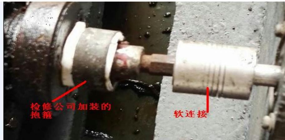
8#溢洪门旋转编码器与滚筒连接处结构
