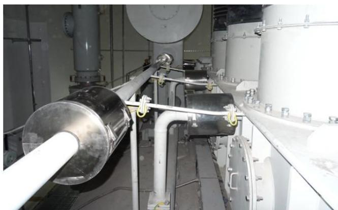
图 1 加装防护罩后的波纹管
