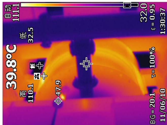
图 2 2B 低压侧 B 相与 IPB 接口处红外测温图 (时间 2015. 06. 05 21:30, 环境温度 28°C, 测温最高值: 110.1°C)
