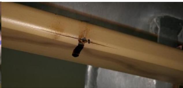
图 3 辅助绝缘拉杆放电图（二）
