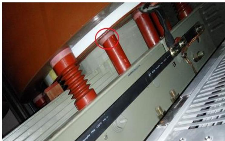
图 22 某站 1 号厂用变线圈下端部支撑绝缘子垫块被压缩变形部位
