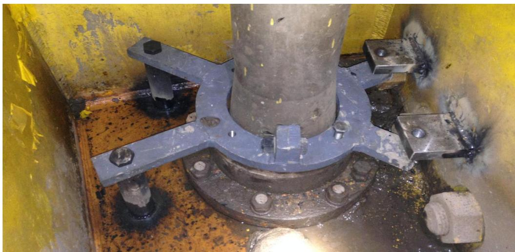
顶盖组合缝处导叶中轴座异性压板效果图
