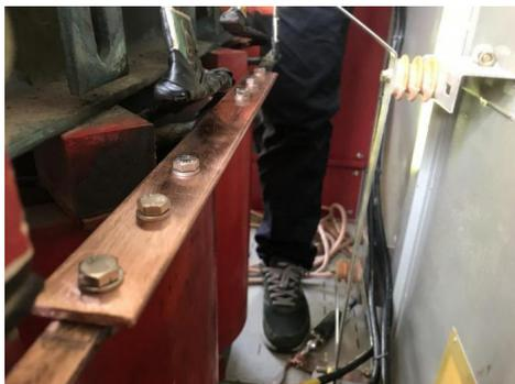
图2 烧损的铜排并接一块铜排
