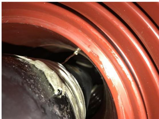
图3 铜丝替代烧损弹簧进行连接
