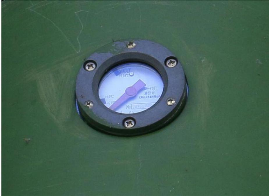
B 相套管油位显示偏低图
