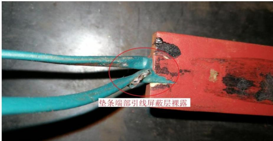
图 5 垫条端部引线屏蔽层裸露 (1F 358 槽)
