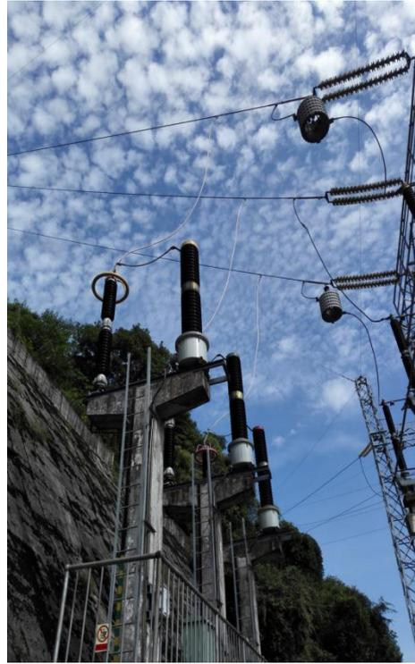
图 18 未加装出线避雷器的线路情况图 19 某站龚九一线 6E 加装出线避雷器后的情况
