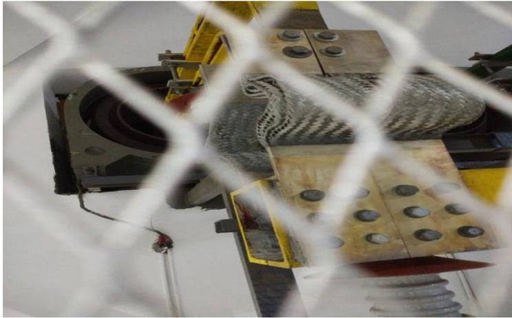
图 13 更换后的中性点软连接
