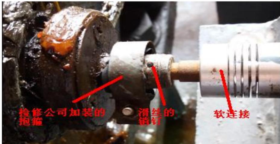
7#溢洪门旋转编码器与滚筒连接处结构
