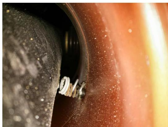
图 2 缠绕铝丝加长弹簧与导体接触
