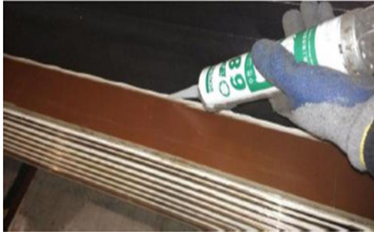
使用硅橡胶封堵内托板与磁极铁芯间隙
